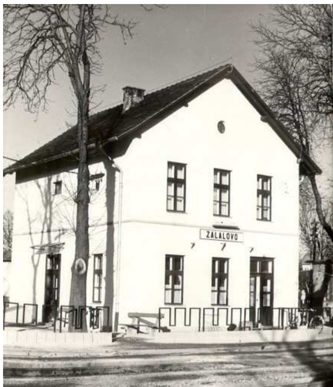
Vasútállomás, Táncsics u. 8., hrsz.: 64/21
