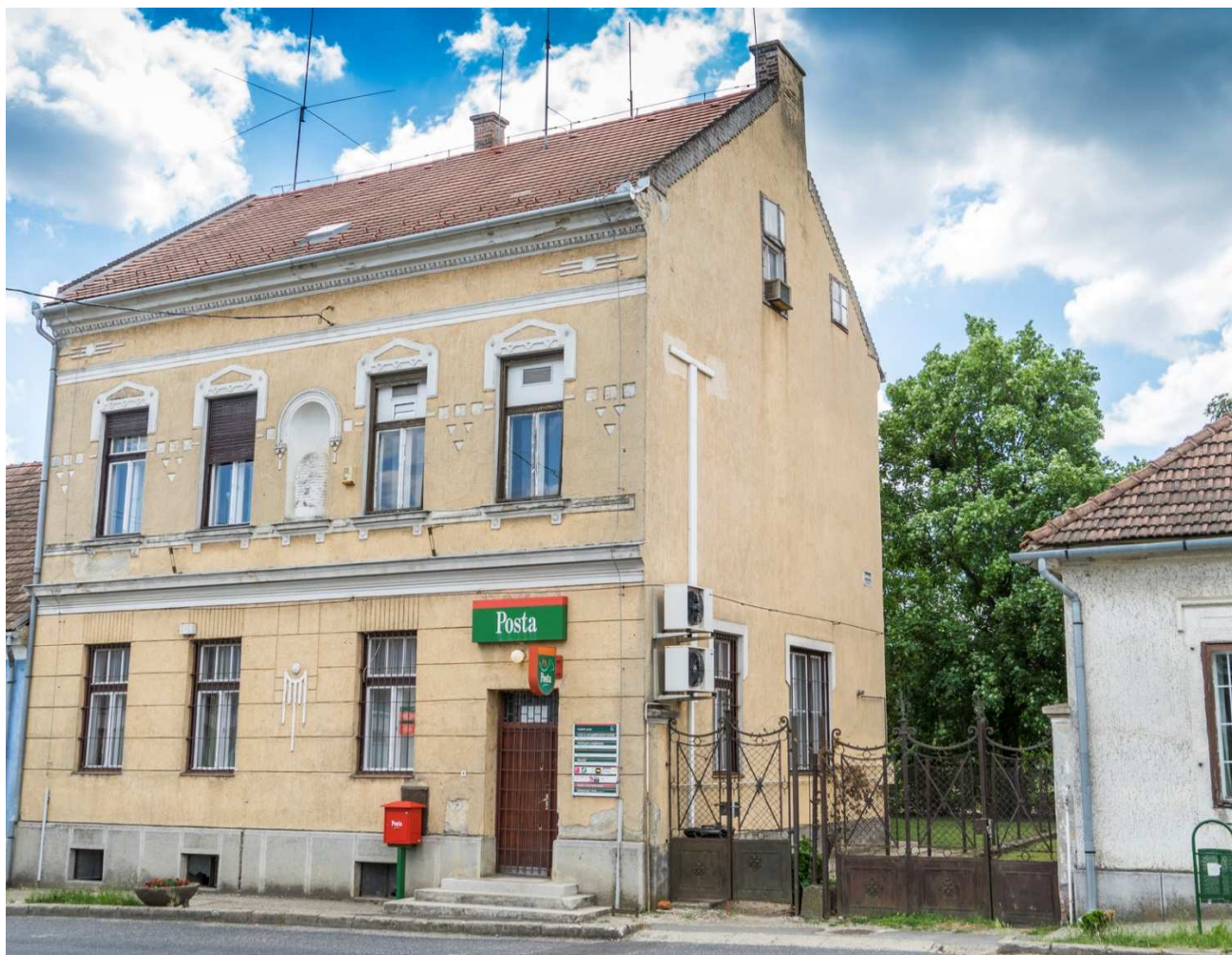
Posta épülete Kossuth u. 7., hrsz.: 1099
